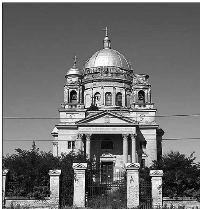
A papdi római katolikus templom és a Csávossy-mauzóleum (2012) Forrás: Saját fénykép.
